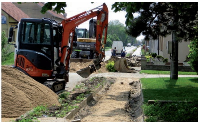
Rekonstrukce chodníku a kanalizace na ulici Nádražní
