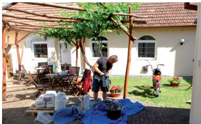
Oprava fasády budovy knihovny a TIC
